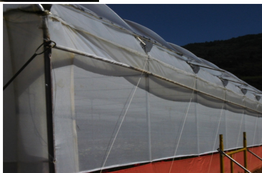
Fig. 12 Invernadero con malla y cortina plástica superpuesta
